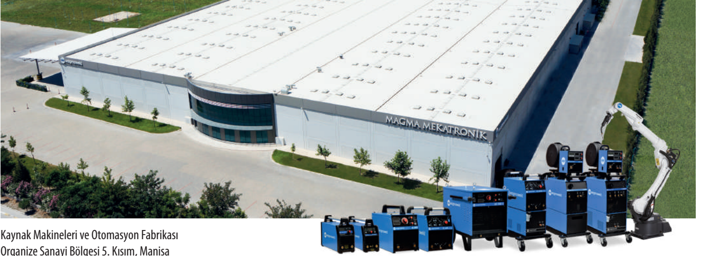
Kaynak Tüketim Malzemeleri Fabrikası Organize Sanayi Bölgesi 2. Kısım, Manisa
